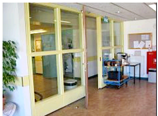
Foto 3: Te grote oppervlakte draadglas in een brandscheiding
