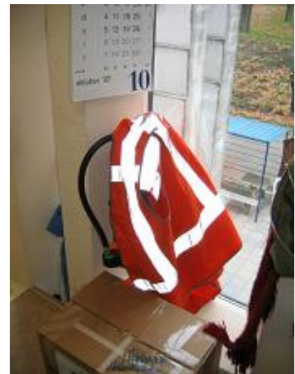
Foto 5: Brandblusser onzichtbaar door BHV-hesje
