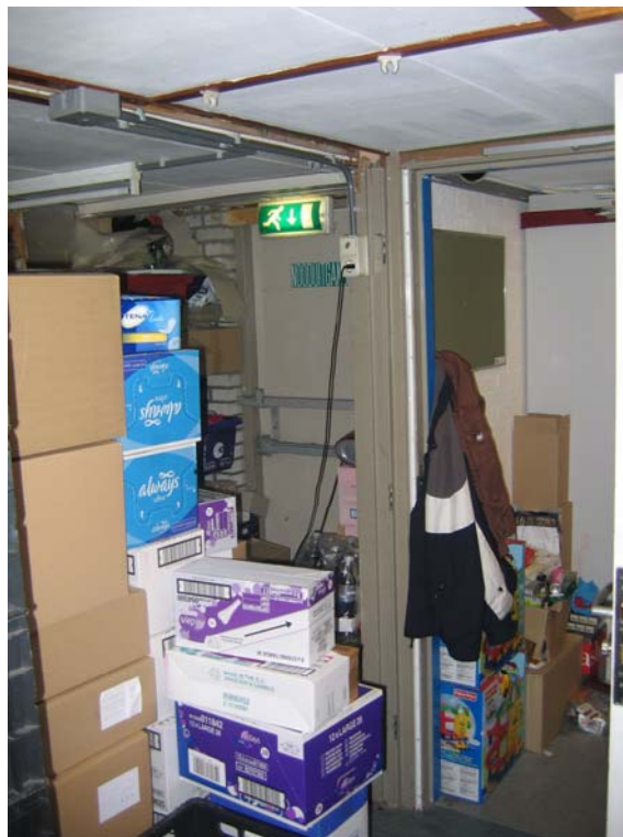
Opslag voor en een extra sluitbalk op de nooduitgang
