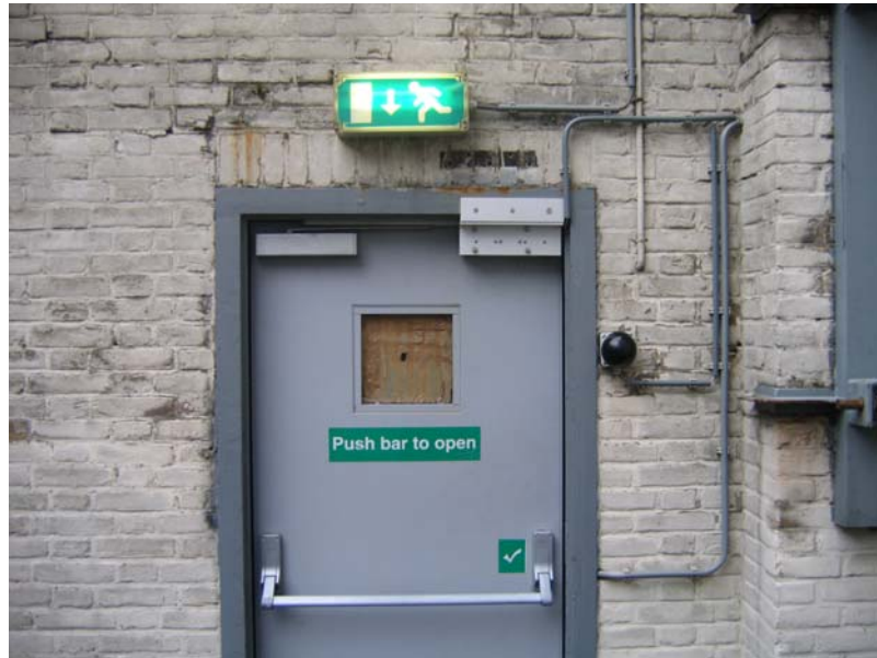
Nooduitgang met pushbar (incl. Engelse tekst) en ontgrendelingsknop
