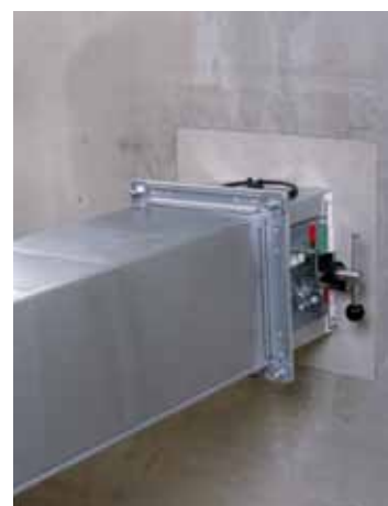
Zorgvuldig afgedichte brandwerende doorvoering
