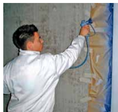
Het opbrengen van brandwerende coating
